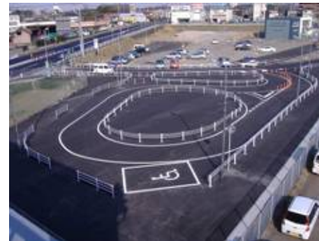
■北柏駅北口暫定駅前広場
