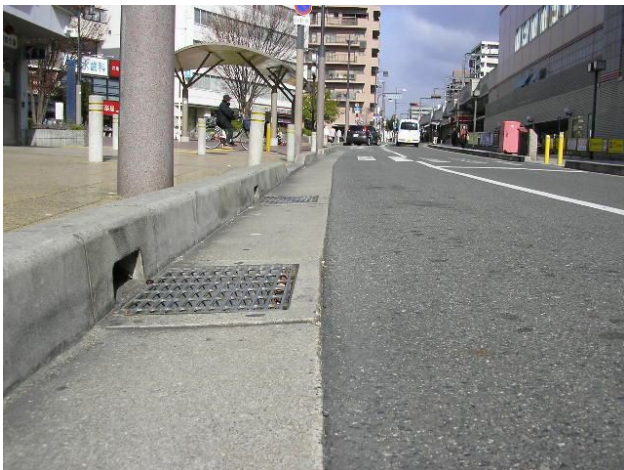
・街渠と舗装の段差解消
