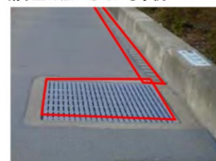
グレーチング蓋の格子間隔を狭め、滑り止め加工している事例
