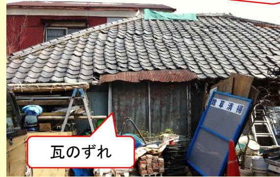
屋根ぶき材料に多少の脱落、軒のたわみ、瓦葺はずれ 軒裏等に一部脱落
