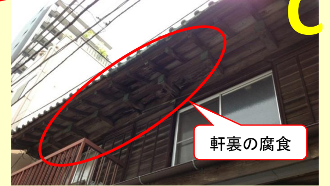
屋根ぶき材料に多少の脱落、軒のたわみ、瓦葺はずれ 軒裏等に一部脱落
