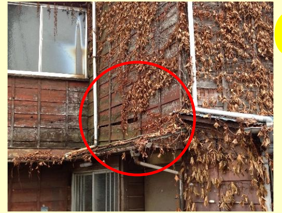
外壁の仕上げ材料の剥落・腐朽・破損により下地一部露出 外壁の仕上げ材の錆びやひび割れ
