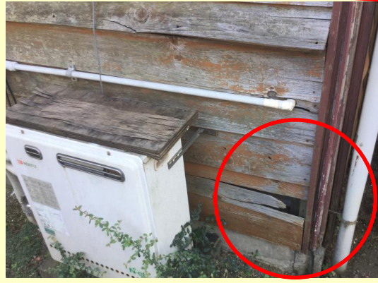
外壁の仕上げ材料の剥落・腐朽・破損により下地一部露出 外壁の仕上げ材の錆びやひび割れ
