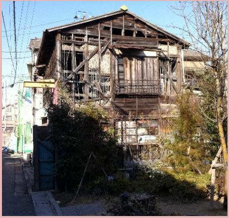
外壁の仕上げ材料の剥落・腐朽・破損により著しく下地露出 壁を貫通する穴、ひび割れ著しい
