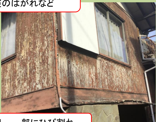
ひび割れあるが危険性無し、一部にひび割れ
