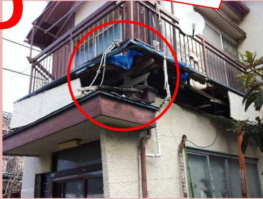
屋根が著しく変更、穴が開く、著しい脱落、軒裏等に著しい脱落
