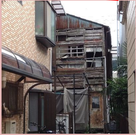
外壁の仕上げ材料の剥落・腐朽・破損により著しく下地露出 壁を貫通する穴、ひび割れ著しい
