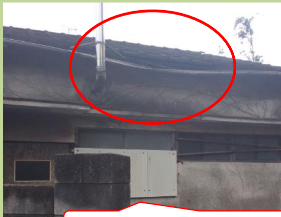
屋根ぶき材料に一部ずれ(瓦葺のぞく)
