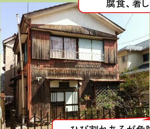
ひび割れあるが危険性無し、一部にひび割れ
