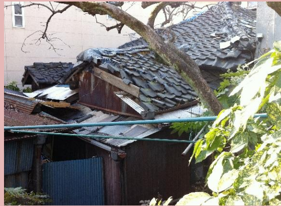
屋根が著しく変更、穴が開く、著しい脱落、軒裏等に著しい脱落
