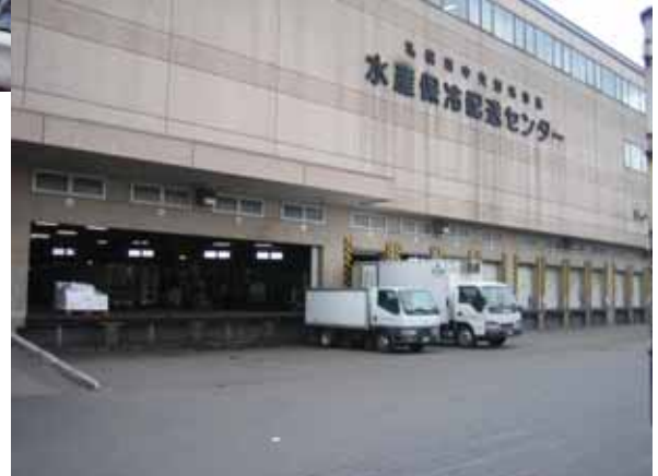
図．ドックシェルター（蛇腹式開閉設備）を備えた配送センターの例
