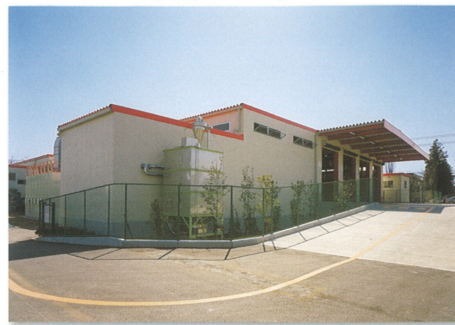
《プラスチック製容器包装 圧縮保管施設外観》
