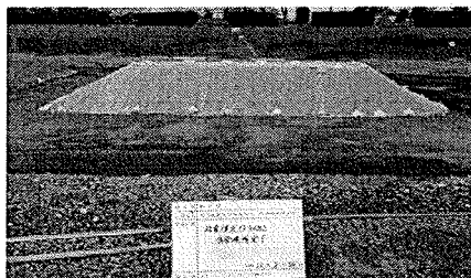
土砂流失防止用ブルーシート+ネット
