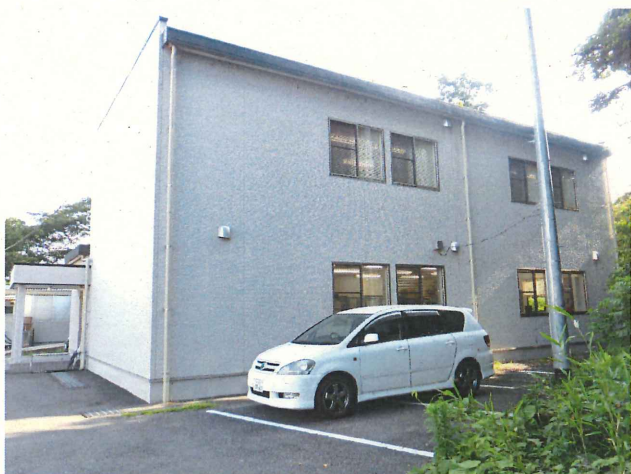
⑨ 事務所・倉庫棟
