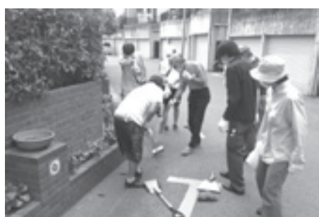
▲除染作業の様子
