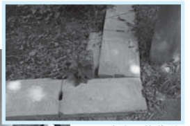
除染と修復後(現在)
