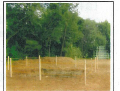
汚泥埋設用の穴
