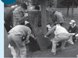
公園にある樹木の根元の土を除去
