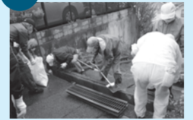
側溝内の土砂を除去
