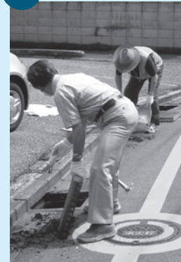
集水ますの中の堆積物やグレーチングに詰まった土や苔を除去
