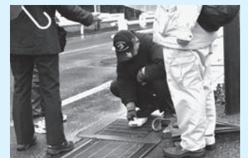
道路の側溝を測定
