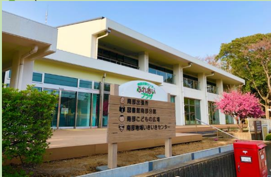
市民活動拠点（南部近隣センターリニューアル） （資料）地域づくり推進部
