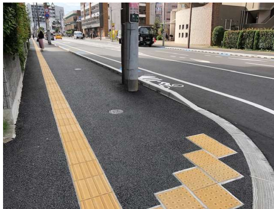
■ 南柏駅前線（施工後）
