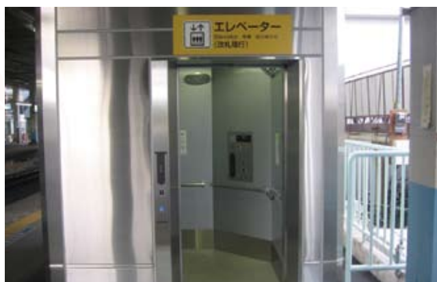
■ 増尾駅エレベーター
