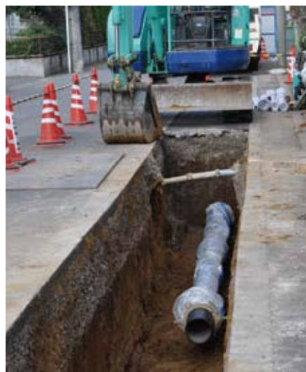
■ 配水管の改良工事
