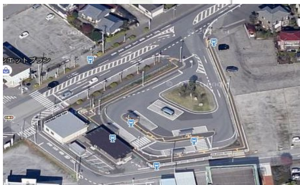
沼南庁舎バス乗継場(現況写真)
