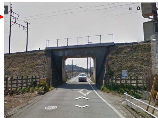
逆井架道橋 現況
