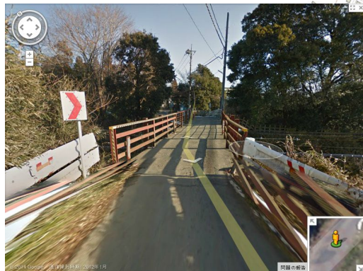
藤心跨線橋 現況
