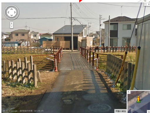
逆井跨線橋 現況
