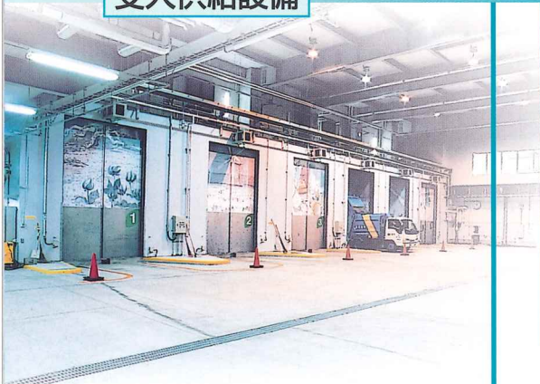
■プラットホーム 搬入車のごみを投入する場所です。
