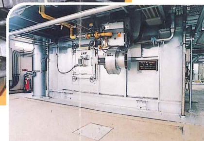
しょうきゃくろ がいかん ■焼却炉 (外観)
