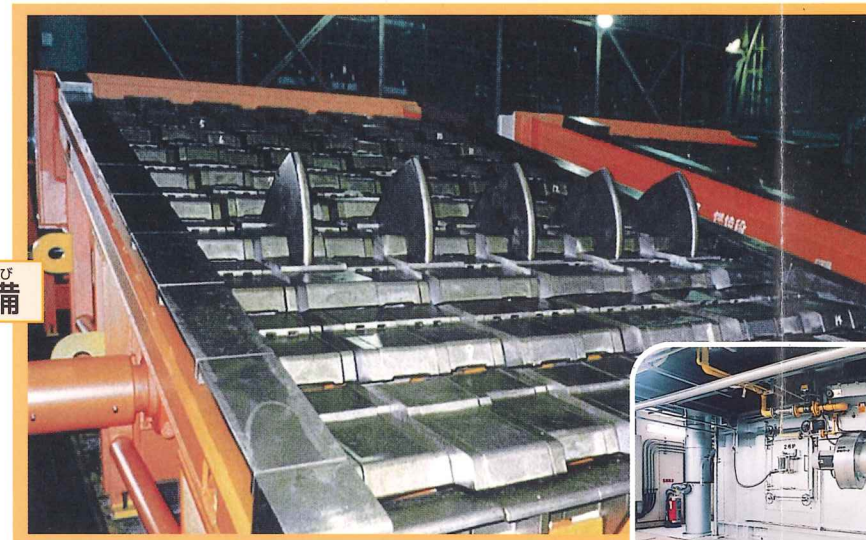
しょうきゃくろ ない ぶ ■焼却炉 (内部) 投入ホッパへ運び込まれたごみを連続的に移送、攪拌し、850℃以上の高温で完全に燃焼・灰化して排出する一連の機能をもった焼却炉で、階段状の火格子と耐火レンガで構成されています。
