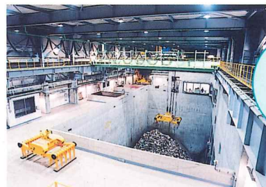
■ごみピット・ごみクレーン 運び込まれたごみは、一時ごみピットに貯留されます。ここではおおよそ1,800トン(6,000m 3 )のごみを貯留できます。
