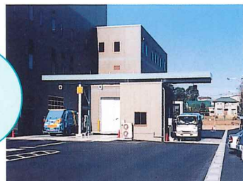
けいりょうどう ■計量棟 搬入車で運ばれたごみを計量します。
