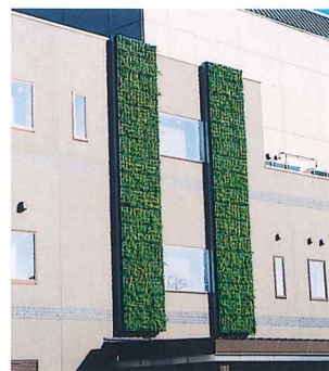
■壁面緑化により緑の景観を保持
