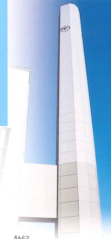
えんとつ ■煙突 鉄筋コンクリートの外筒と鋼製の内筒(高さ100m)で構成されており、排ガス処理設備を通った排ガスが大気へ排出されます。
