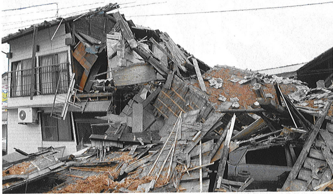
最大震度7の地震により、大きな被害が発生しました。
