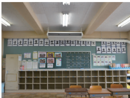
▲設置完了！屋外の工事へ移ります
