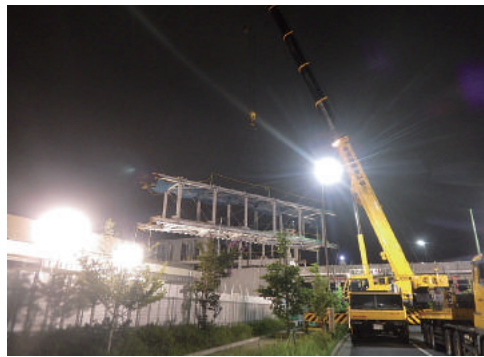
▲道路上に大きなクレーンを組み立て、上空通路をつり上げて運ぶ、大規模な工事です
