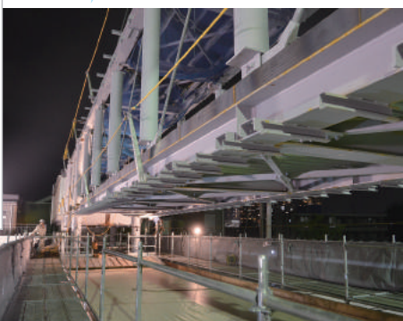
▲道路上に大きなクレーンを組み立て、上空通路をつり上げて運ぶ、大規模な工事です
