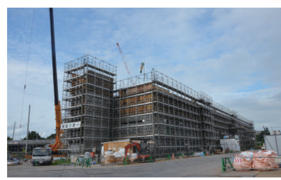
▲大きな校舎は今まさに建設作業中
