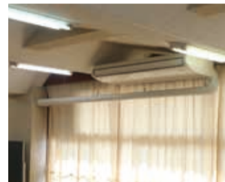
▲このようにエアコンが設置される予定です
