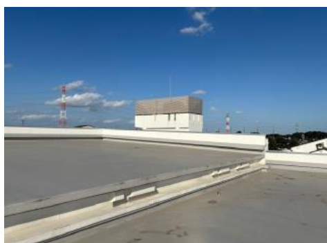
防水改修後の屋上(監査人撮影)
