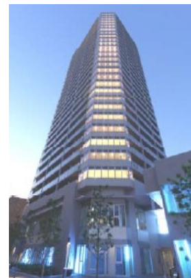
■柏駅東口A街区第二地区
