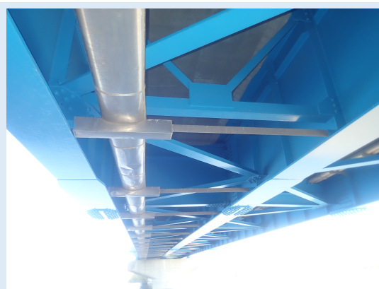
修繕後(平成 28 年度)
