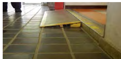
バリアフリーではない建物の内部
