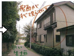
集落内では壁面が全て見えているような新たな住宅も見られる
