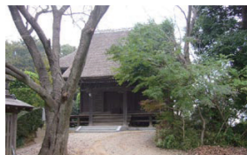
茅葺屋根の福寿院
