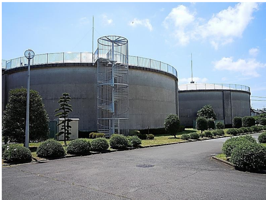
＜第六水源地＞ コンクリート配水池 5000m 3
