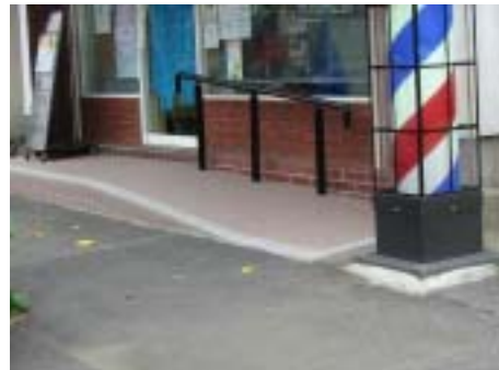
スロープを設置している例(増尾)
