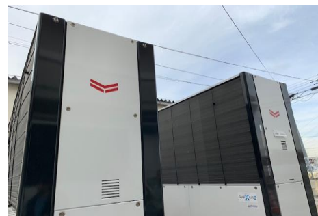
図 沼南庁舎のコージェネレーションシステム
