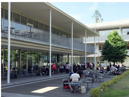
広場状空地に面してガラス面を用い、屋内外の連続性を創出している事例
