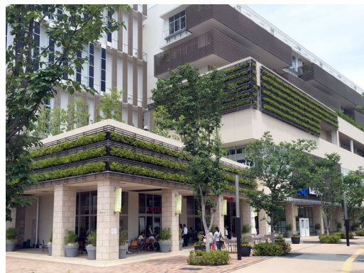
視覚的な緑量を増やすため、高木を沿道に配すとともに、壁面緑化等で補っている事例
