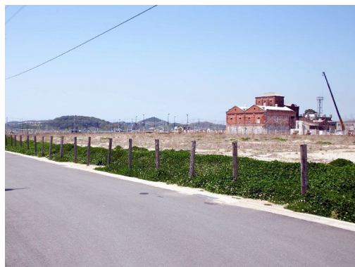
敷地のきわを播種で緑化し、修景するとともに土砂の飛散を防止している例
