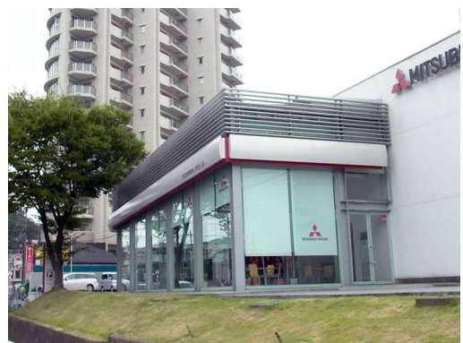
道路との高低差を芝の法面によって処理している例。
