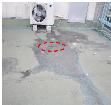
防水シートの剥がれ，劣化
