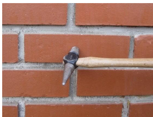
打診による浮きの確認
