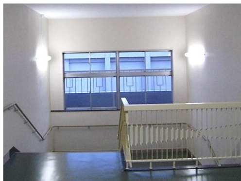
手すり・フェンスのぐらつきの確認
