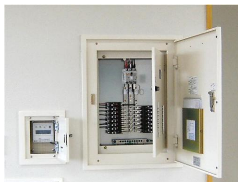
異音、異臭、開閉・施錠不良の確認
