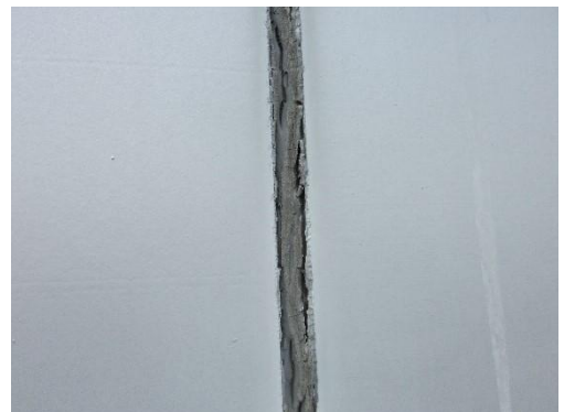
外壁目地の亀裂, 硬化
