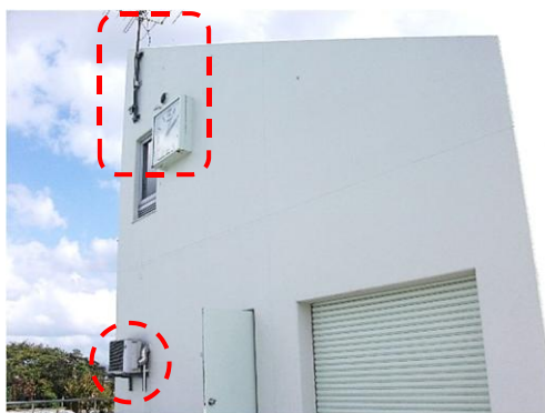
壁面設置物の落下の危険を確認 (手が届く箇所はぐらつきを確認する)
