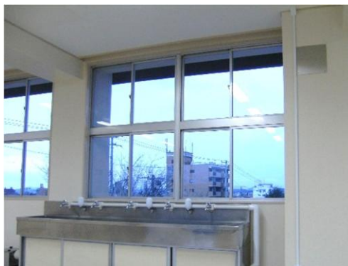
窓のがたつきや落下の危険の確認
