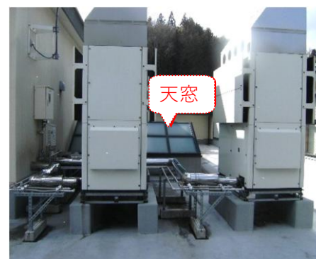
屋上入口の施錠確認
