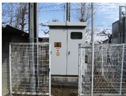
扉やフェンスの施錠の状態確認
