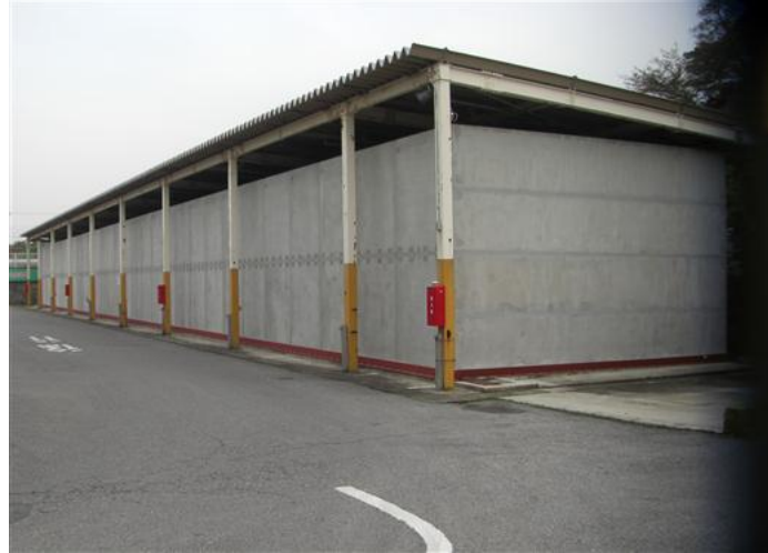
仮保管庫（ボックスカルバート）
