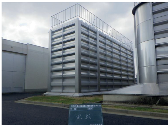
《受水井の更新工事》
