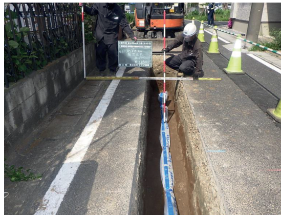
《配水管改良工事の様子》
