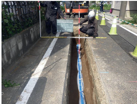
配水管改良工事の様子
