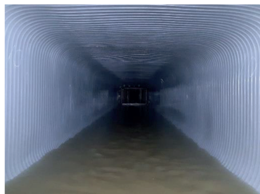
《更生工法による改築工事(工事前後)》
