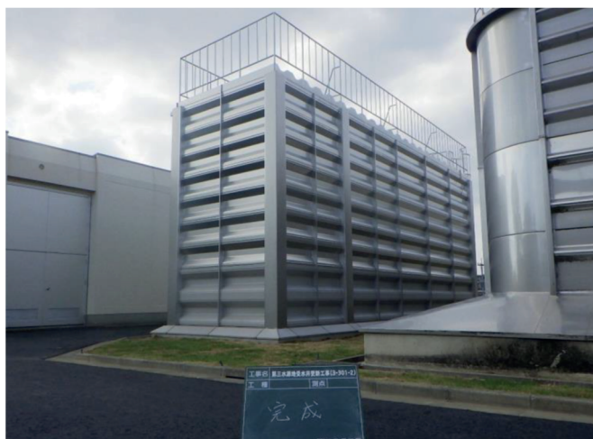
《受水井の更新工事》
