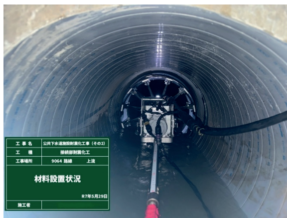
《対策工事の様子》
