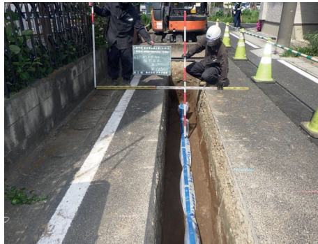
配水管改良工事の様子
