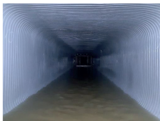
更生工法による改築工事（工事前後）
