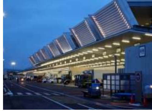
▲屋根・庇、荷捌きスペース確保のイメージで、ウイング車でも車両全体が屋根・庇下に入り、荷捌きができる場所を確保している（東京都中央卸売市場豊洲市場）
