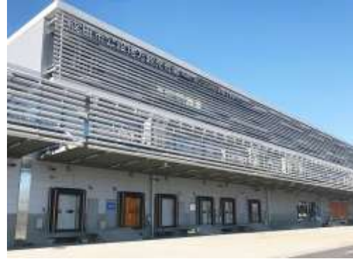
▲ 庇やドックシェルター、閉鎖型の卸売場（低温売場）のイメージで、庇が伸びておりドックシェルターにより外気に触れず商品の入荷が可能である（成田市公設地方卸売市場）
