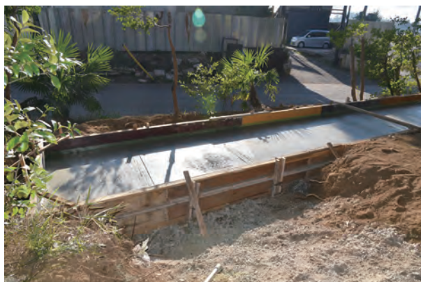
基礎コンクリート打設
