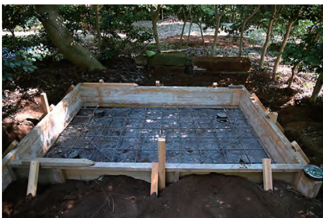
コンクリート型枠設置状況
