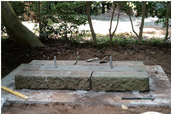
アンカーボルト設置作業後全景
