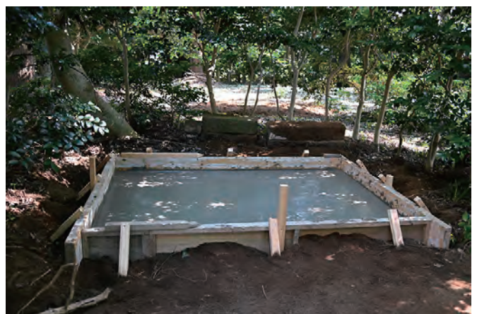
コンクリート流し込み後状況
