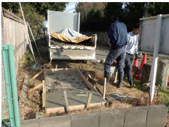
コンクリート流し込み作業状況
