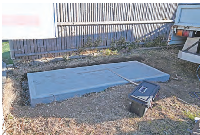
コンクリート基礎完成後状況
