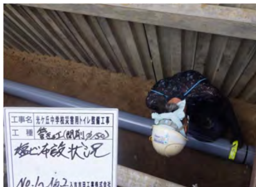
対策工事の様子
