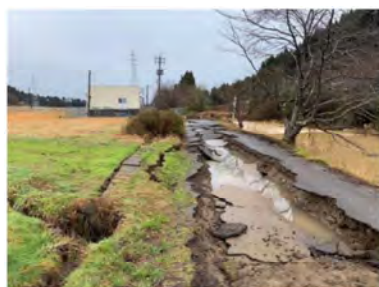
水源から浄水場へ送る導水管の被災
