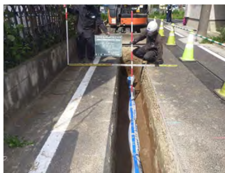
配水管改良工事の様子
