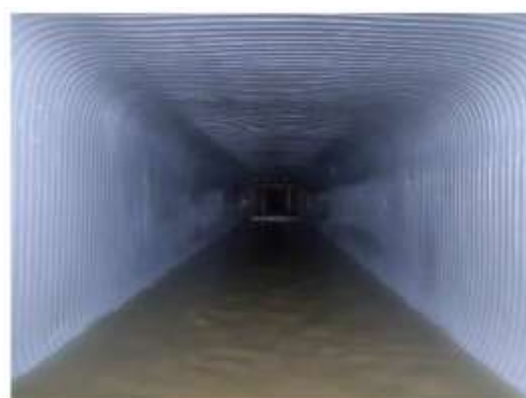
更生工法による改築工事(工事前後)
