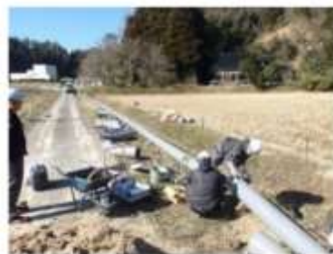
区域の下水を集約し処理場へ送る圧送管の被災
