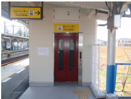
■高柳駅構内エレベーター
