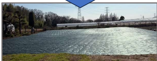
防草シート設置
