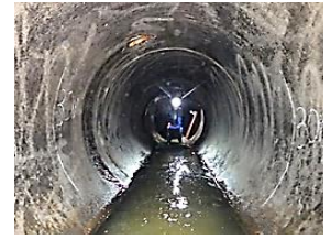
改築工事（管更生）施工前
