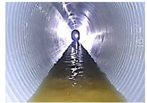
改築工事（管更生）施工後
