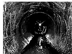
改築工事（管更生）施工前
