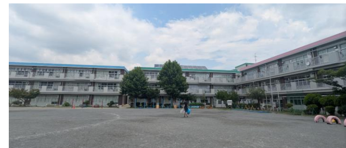
参考①：花野井小学校大規模改修工事例
