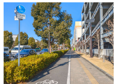
植樹帯により自動車と分離された良好な歩行環境 (3・2・40 十余二船戸線)
