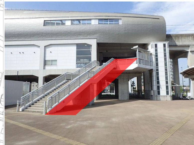
東口設置箇所
